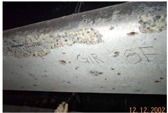
Photo 3. Girder 8E Flange Soffit
